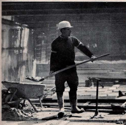
Die Abdichtung der Sohle wird mit einer Betonschicht gegen Beschädigungen geschützt.
