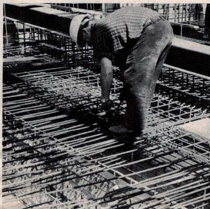
Die Bewehrung der Sohle wird verlegt.
