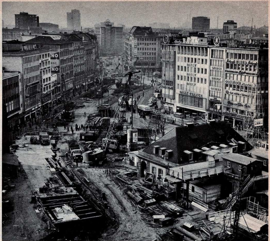
So sah es an der Hauptwache in Frankfurt aus, als dort der U-Bahnhof gebaut wurde.
