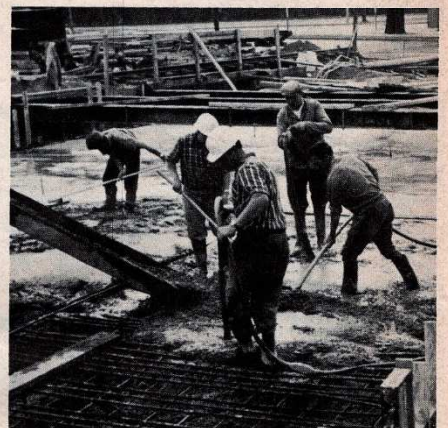
Die Tunneldecke wird betoniert.
