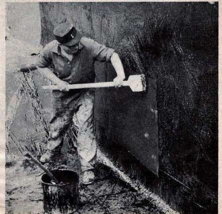
Für die Abdichtung des U-Bahn-Tunnels werden mehrere Lagen Bitumenpappe verklebt.
